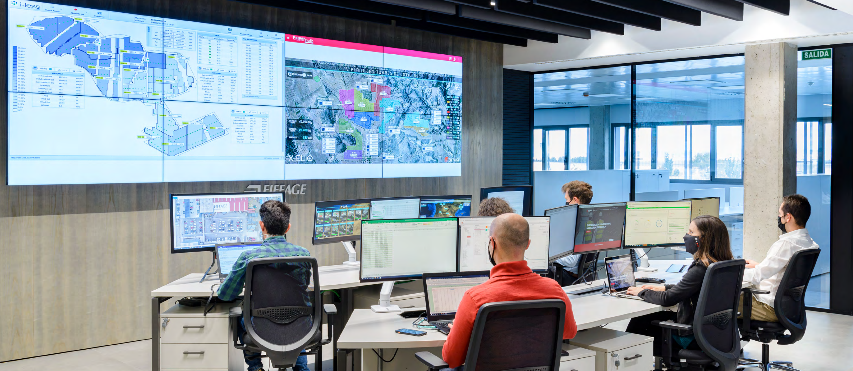
Sala de Control y Operación
