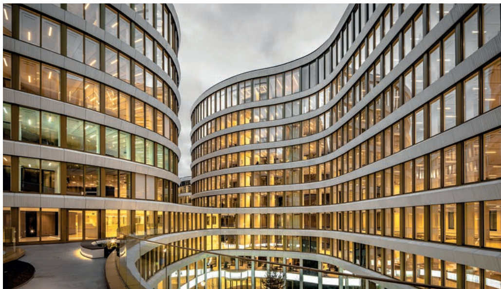
Sede de BNP Paribas Fortis en Bruselas, entregada en noviembre de 2021 por Eiffage Benelux
