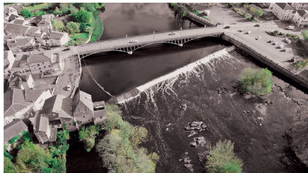
Microcentral hidroeléctrica en Teyssode (Tarn), proyecto desarrollado por Eiffage Concessions
