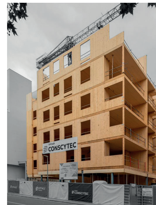
Madera integrada en el edificio residencial urbano – 21 viviendas laminadas cruzadas CLT construidas en Sabadell (España) por Conscytect, filial de Eiffage Energía en España
