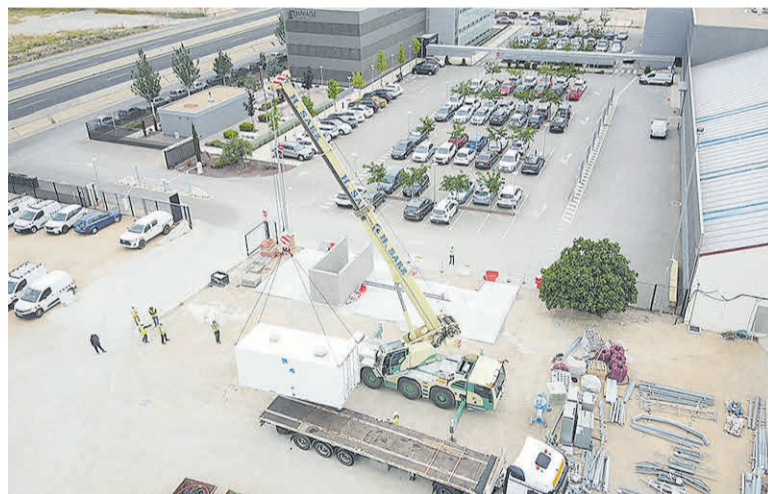
Un momento de los trabajos de instalación. / EIFFAGE
